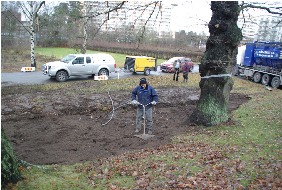
Figur 1. Luckring inför en markvitalisering
