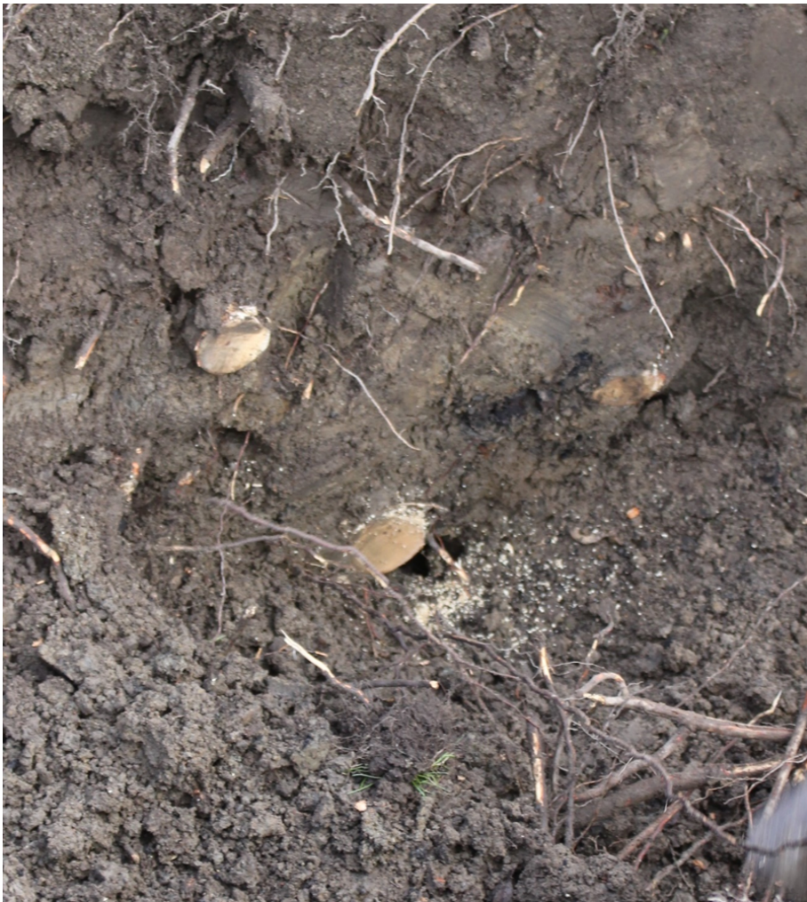
Figur 4. Korrekt beskurna rötter vid schakt.
