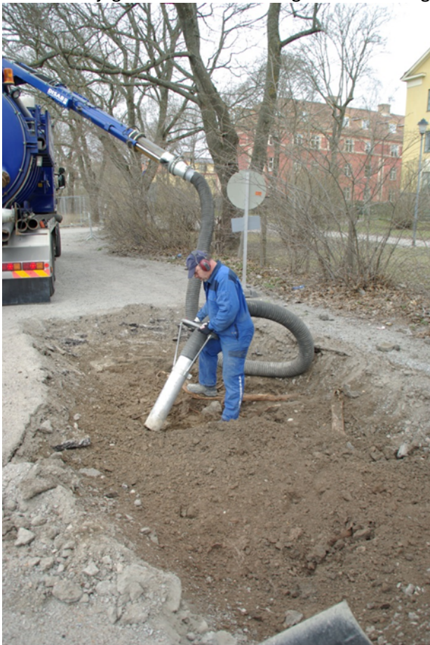
Figur 2. Rotkartering med vakuumschakt.
