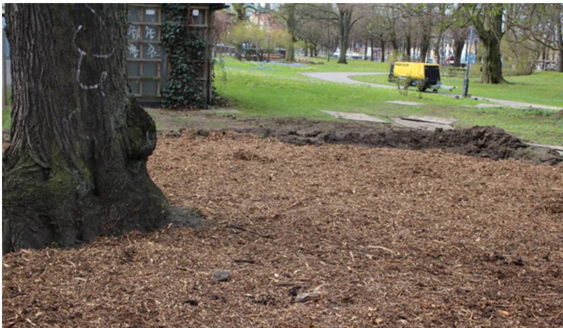
Figur 2. Färdigutlagt mulchlager vid markvitalisering.
