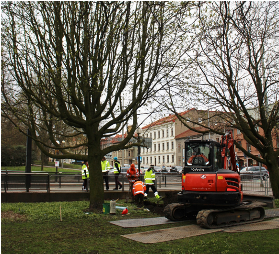
Figur 2. Tillfälligt markskydd där trycket från grävmaskinen fördelas på en större yta.
