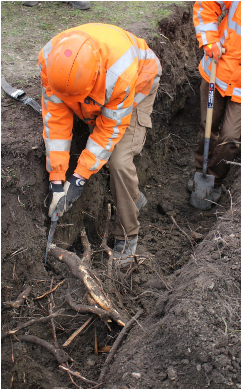
Figur 3. Trärötter som måste avlägsnas vid schakt beskärs med beskärningsverktyg (handsåg).
