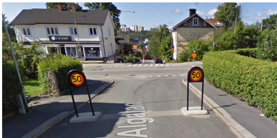
Figur Fel! Ingen text med angivet format i dokumentet. -14 Exempel på hastighetsskyltar från en sidogata i Södertälje med 30 km/tim, där hastigheten är 50 km/tim på huvudgatan i nuläget. I hastighetsplanen föreslås 40 km/tim på huvudgatan, vilket innebär att 2 nya skyltar skulle behöva bytas ut, befintliga stolpar och 30-skyltar kan behållas.
