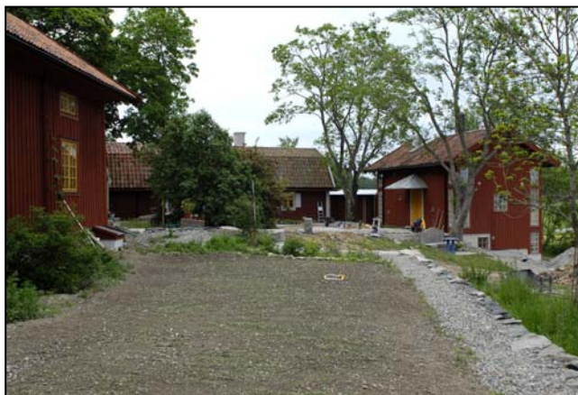
Rinkeby från gårdssidan under pågående arbete. Stallet närmast i bild.
