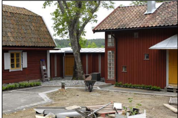
Förbindelsegång. Pågående arbete med gården.
