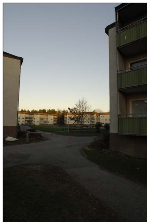
Flerbostadshus i kv Sågen.
