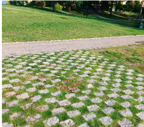
Genomsläpplig markbeläggning på parkeringsytorna.
