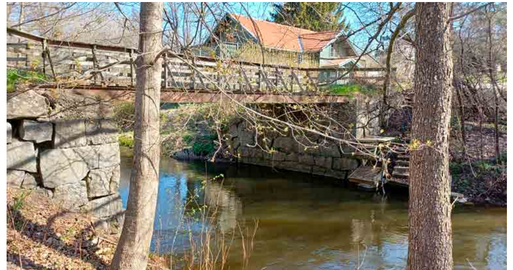
Den äldre broförbindelsen över Sigtunaån
