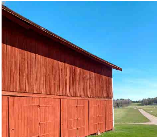
Ekonomibyggnad vid Nibble gård
