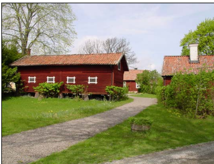
Magasinet närmast, bagarstugan med bryggghus intill.
