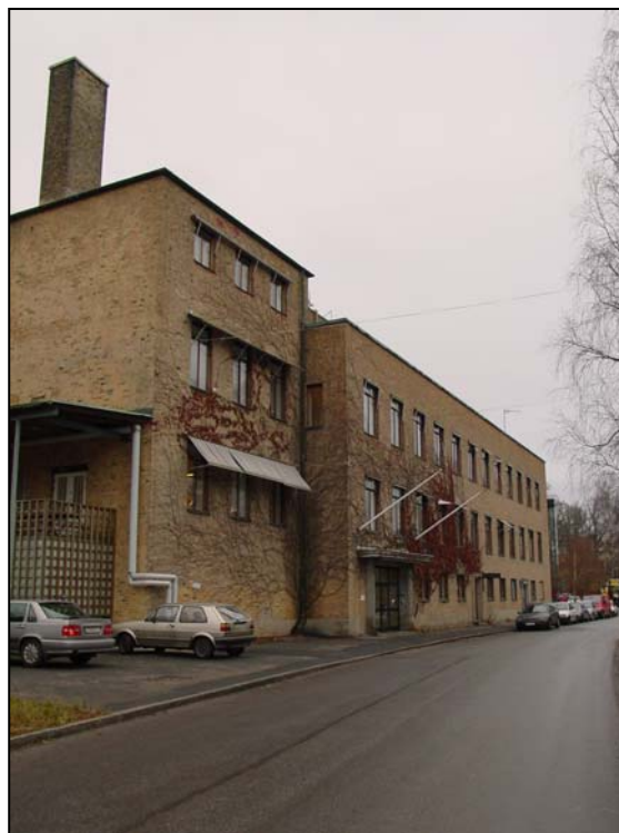
Västra fasadens norra del.
