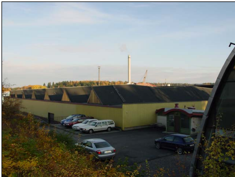
Hallbyggnaden med sitt vågformade sågandstak.
