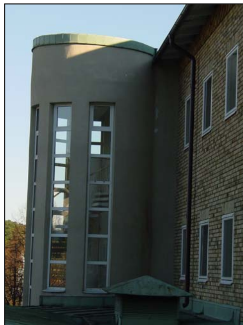
Trapphuset mot Mariekällgatan
