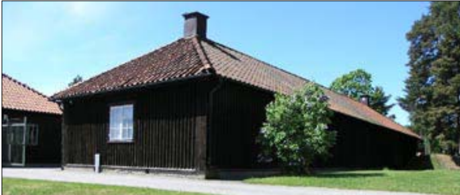
Verkstads- och underhållsbyggnader från 1924 är senare tillbyggnader. Bildnummer lp20050750
