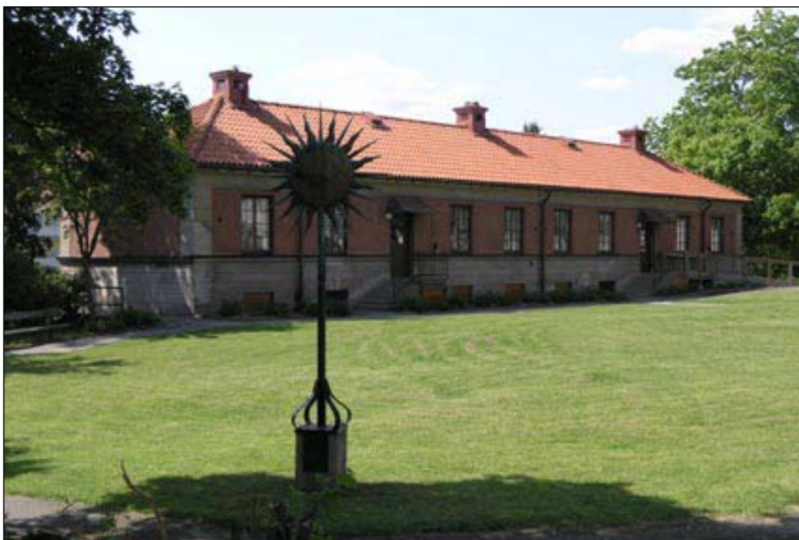
Annexbyggnad från 1923 till Folkets hus i kvarteret Nötviveln. Bildnummer lp20050685
