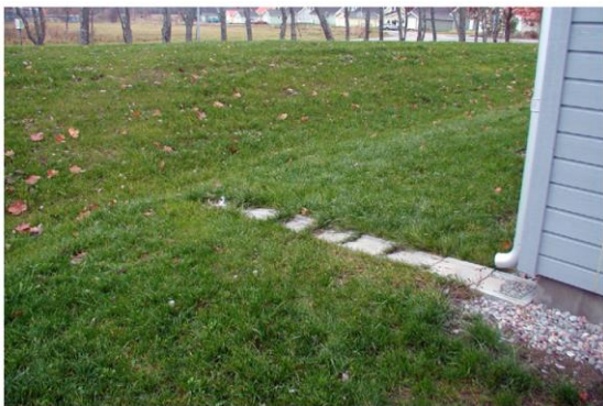
Figur 13. Erosionsskydd för utledning av takvatten från stuprör (Stockholm Vatten och Avfall, 2017a).
