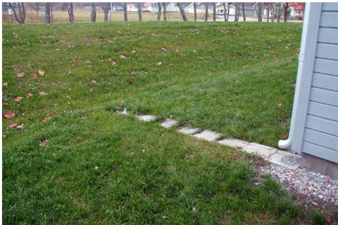
Figur 12. Erosionsskydd för utledning av takvatten från stuprör (Stockholm Vatten och Avfall, 2017a).
