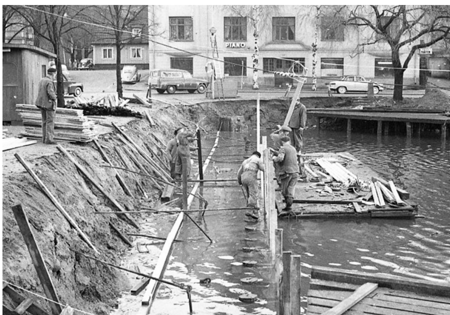
Figur 3.3. Foto från slutet av 1950-talet taget under byggskedet av befintlig kaj vid kv Tellus 5. (Länstidningen Södertälje)
