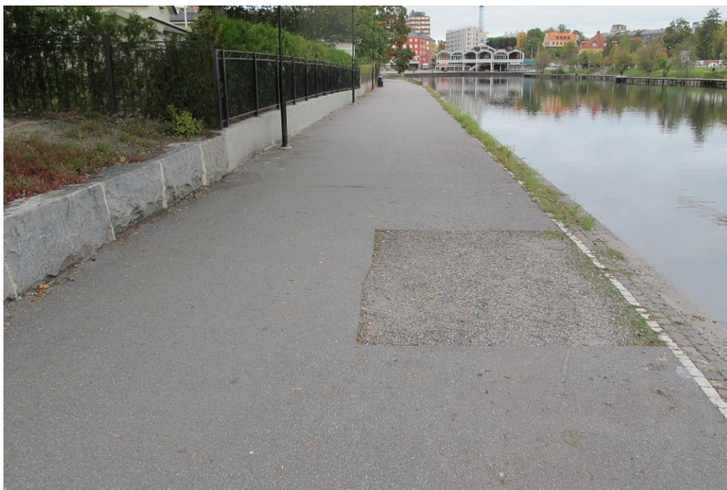
Figur 6.2. Åtgärdat slukhål i sektion 0/025. (KFS 2019-09-25)
