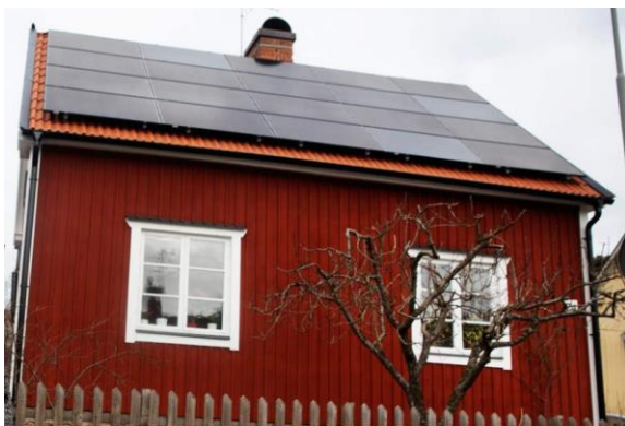
Bedöms kräva bygglov om detaljplanen anger röd takbeläggning
