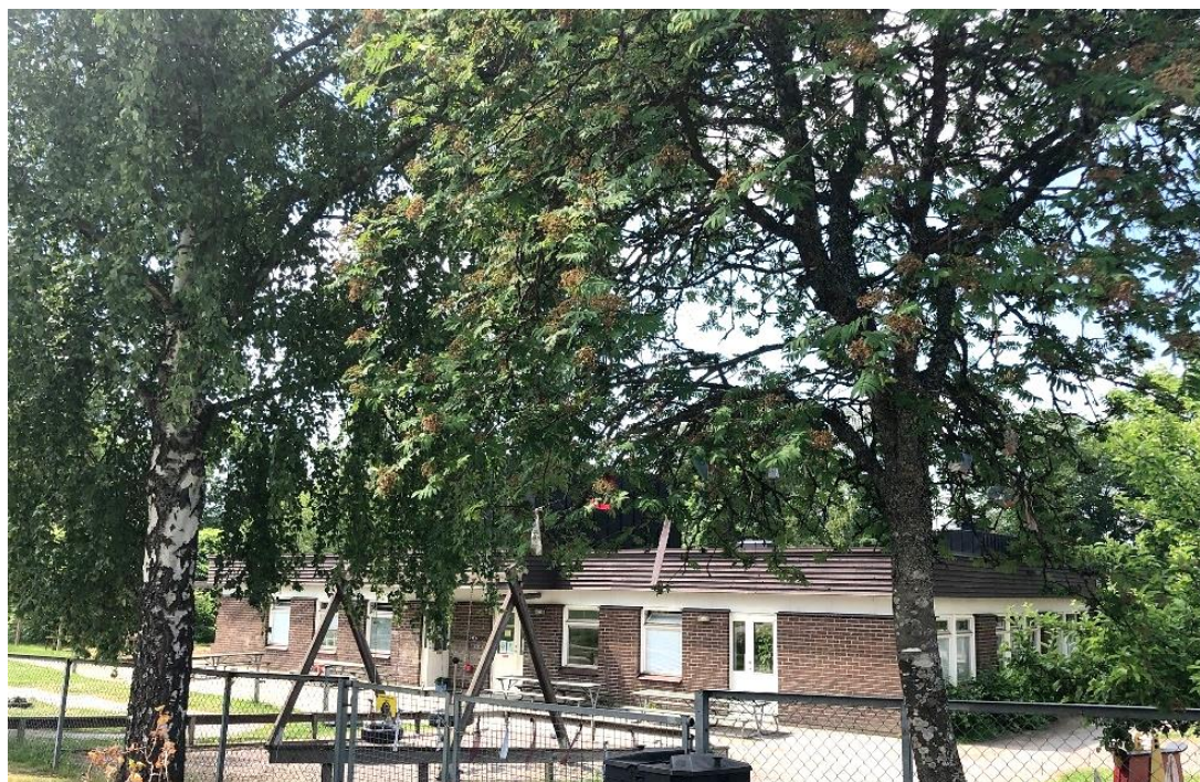
Förskolan Tygeln är en av två liknande förskolor på platsen, här sedd från gc-vägen i norr.
