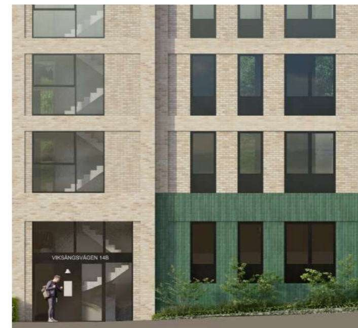
Fönster i svarta smäckra dimensioner och fasadelement i tegel med förskjutningar i olika djup. Skarvarna mellan fasadelementen anpassas till djupförskjutningarna och tegelmönstret för att undvika synliga skarvar.
