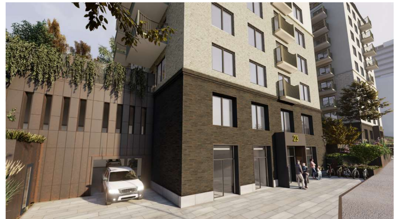
Bostadsvolymerna skjuts fram i förhållande till garaget och bidrar med en rytm längs Viksängsvägen. Det avvikande materialet på garagets fasad, förstärker de olika volymerna.
