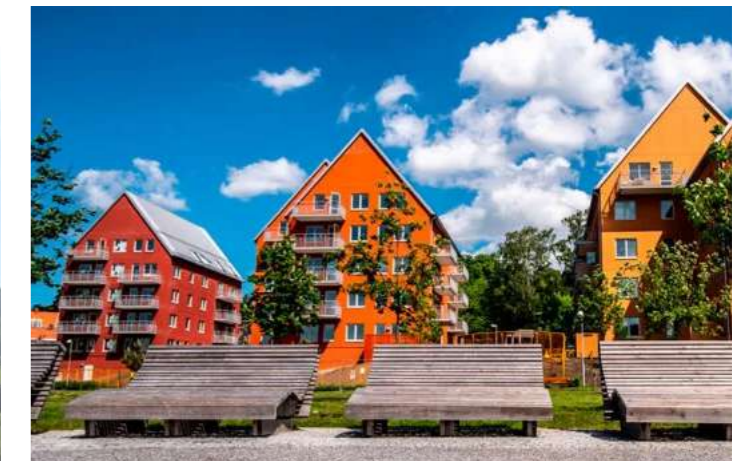
Ny bostadsbebyggelse vid Igelsta strand
