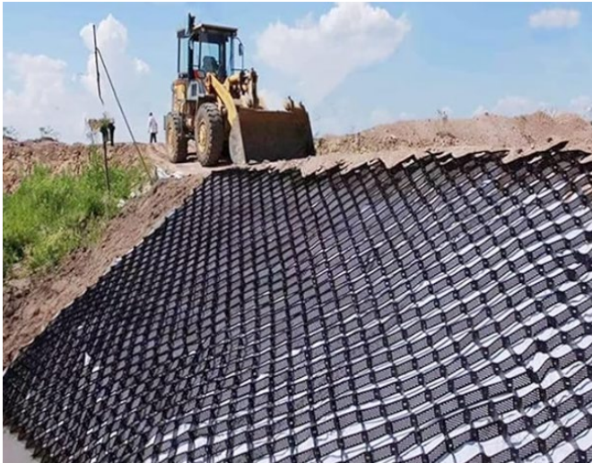
Figur 5. Slänt med erosionsnät
