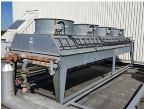
FIGUR 4. LJUDKÄLLA NY18. BEGRÄNSAD TILL DRIFT MED 2 AV 4 FLÄKTAR.
