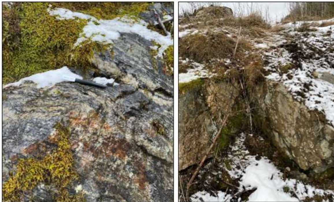
Figur 6. Varierande rostpåverkan på hålltytor och sprickytor i undersökningsområdet.
