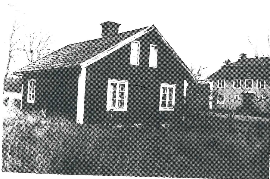
Stamma byggnad i Rävått 11.
