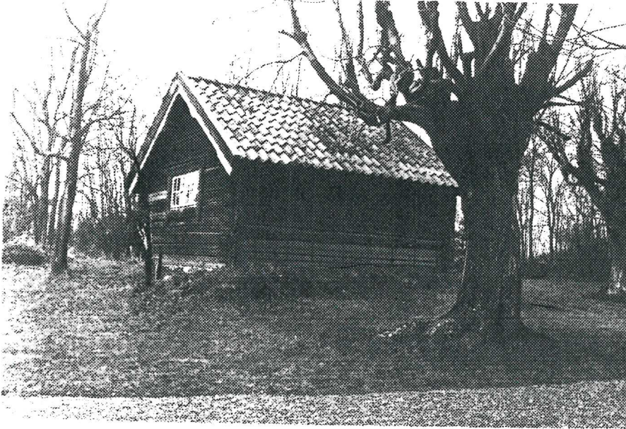
Knuttjärred bod, sekundärt inredd som gäststuga.
