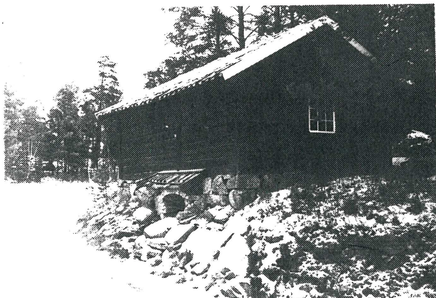
Källarboden från 95V.
