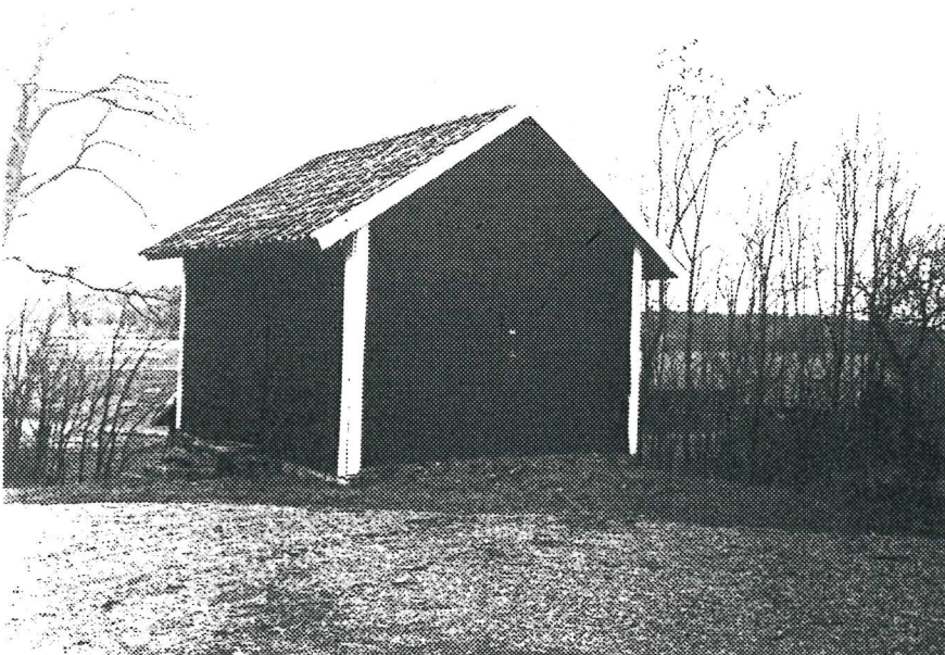
Magasinsbyggnaden nr. 4 från 60.
