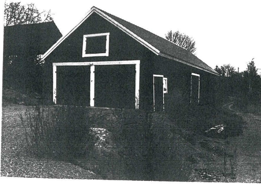
Garagebyggnad nr. 5 från SV.
