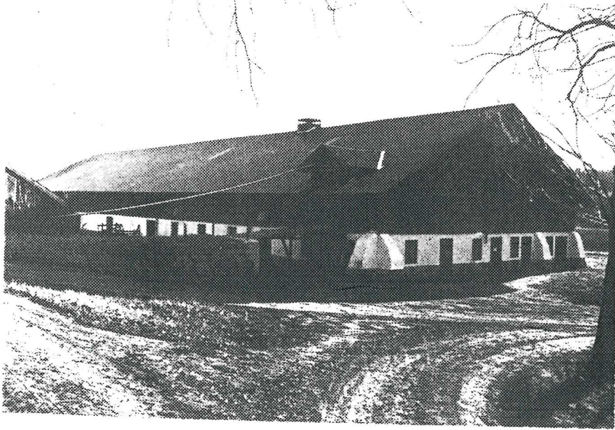
Ladugårdskomplexet från NV.
