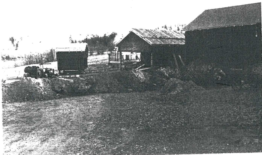
Friluftsmuseet under byggande.
