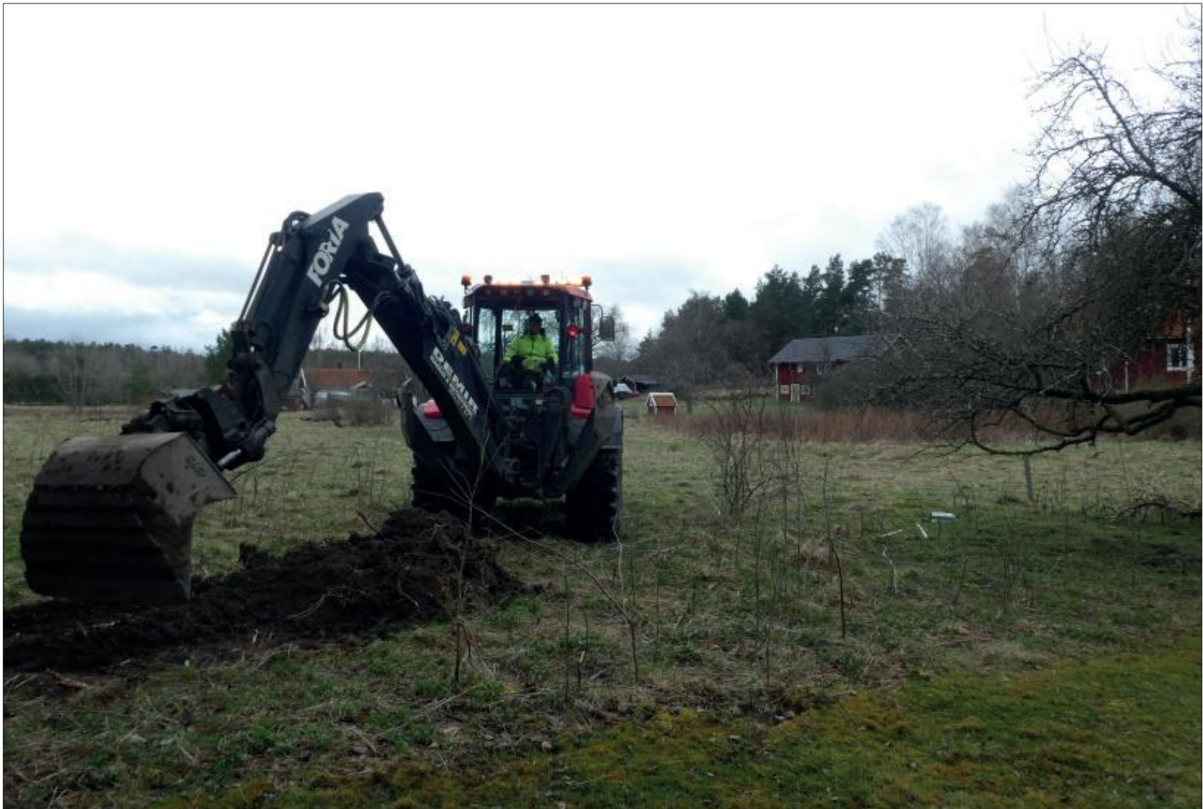
Figur 4. Schaktning i före detta åkermark inom objekt 13. Foto från norr.
