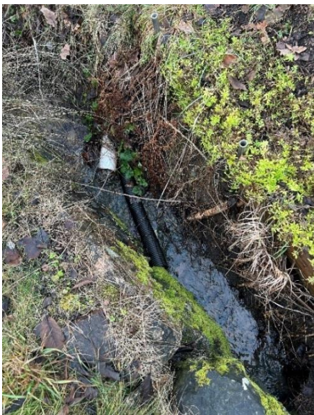
Figur 20. Utloppsrör identifierade vid inmätning, foto av Rickard Pettersson Pontarius
