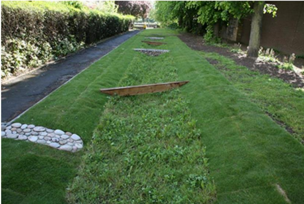
Figur 42. Ett exempel på sektionerat svackdike.
