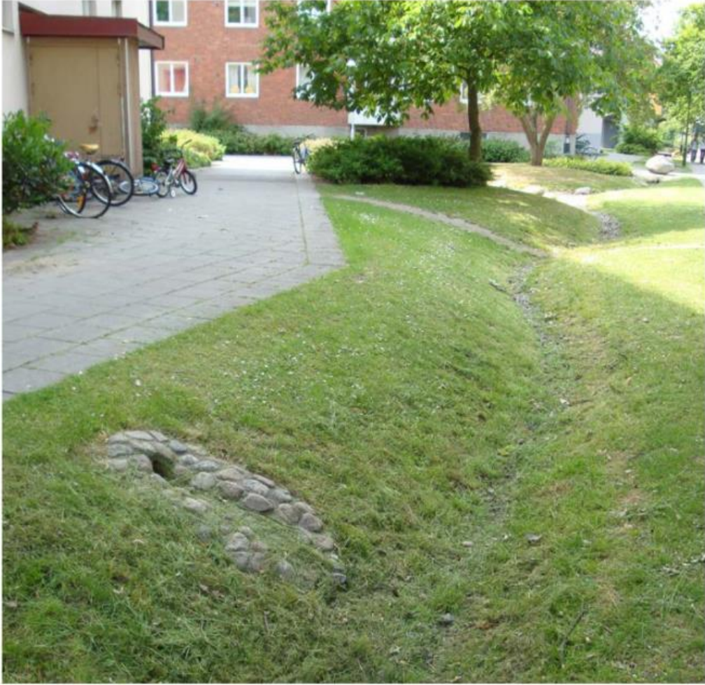
Figur 41. Ett exempel på svackdike.
