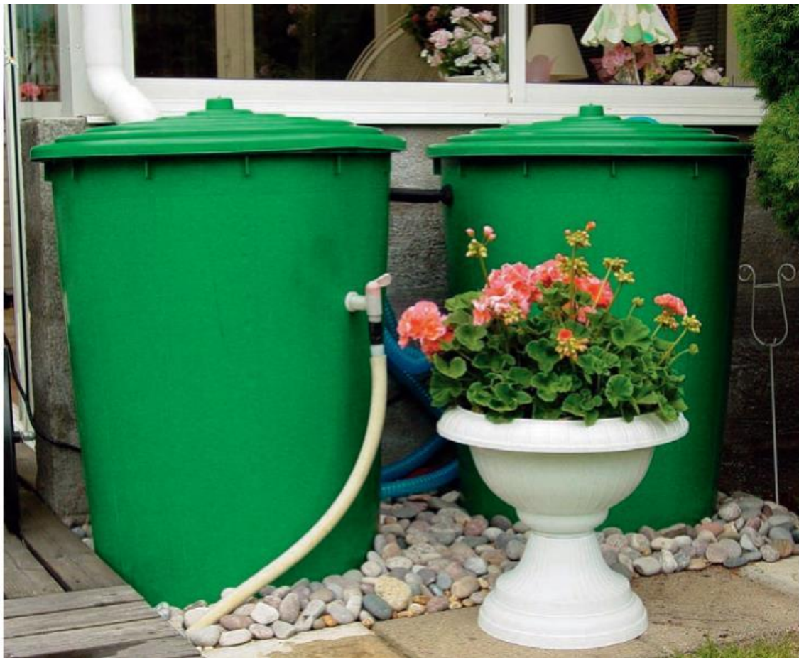
Figur 39. Tunnor med regnvatten och överflyllnadsskydd. ©Svensk Vatten
