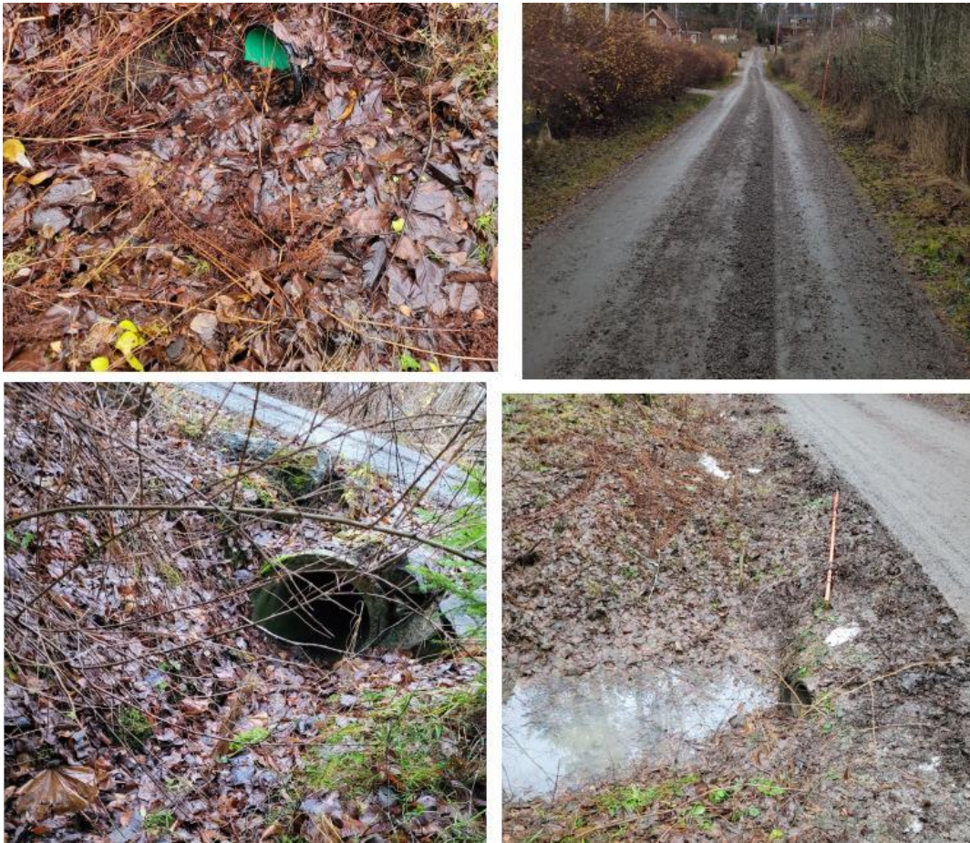
Figur 22. Exempel på avrinning inom trummor inom utredningsområdet. Foton från platsbesök.
