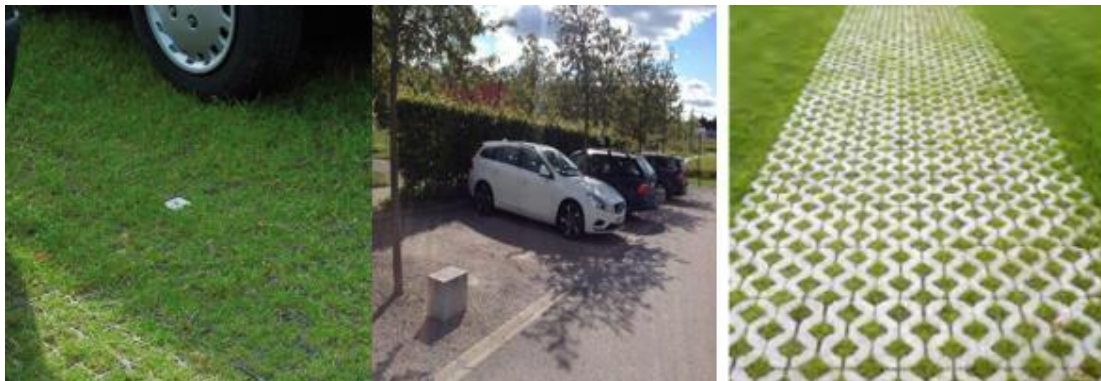
Figur 40. Olika typer av permeabel beläggning på parkeringsytor.
