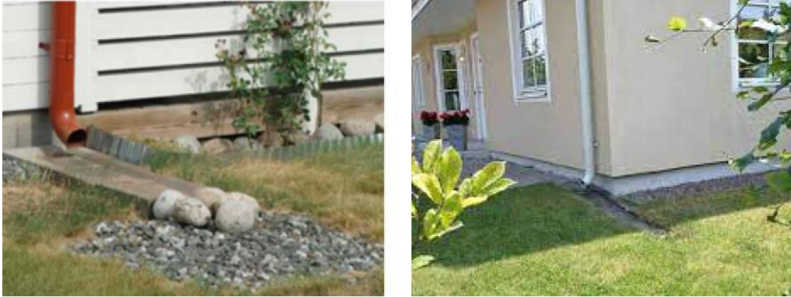
Figur 38. Två alternativ för att avleda takdagvatten till en grönyta.
