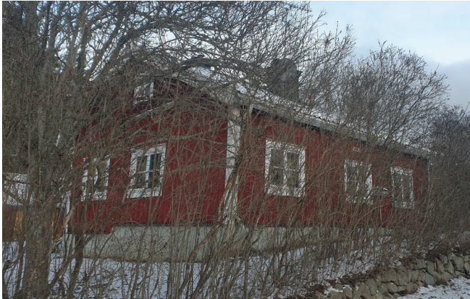
Backa, Vinberga 1:20, byggnad nr. 16
