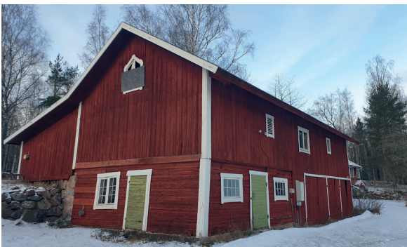
Karlsborg, Vinberga 1:15, byggnad nr. 8
