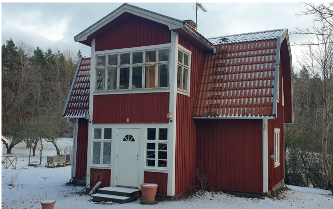
Karlsborg, Vinberga 1:15, byggnad nr. 7
