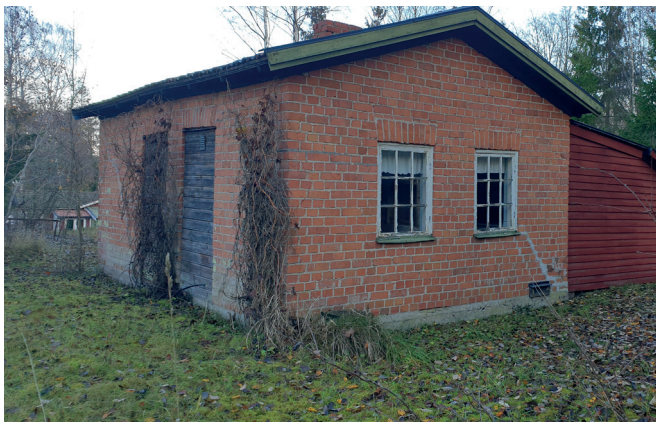
Tegelbruket, byggnad nr.19.
