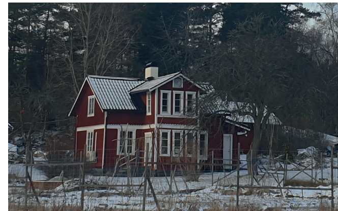
Stenkulla, Vinberga 1:66, byggnad nr. 10
