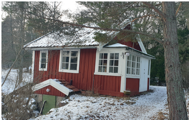
Karlsborg, Vinberga 1:15, byggnad nr. 9
