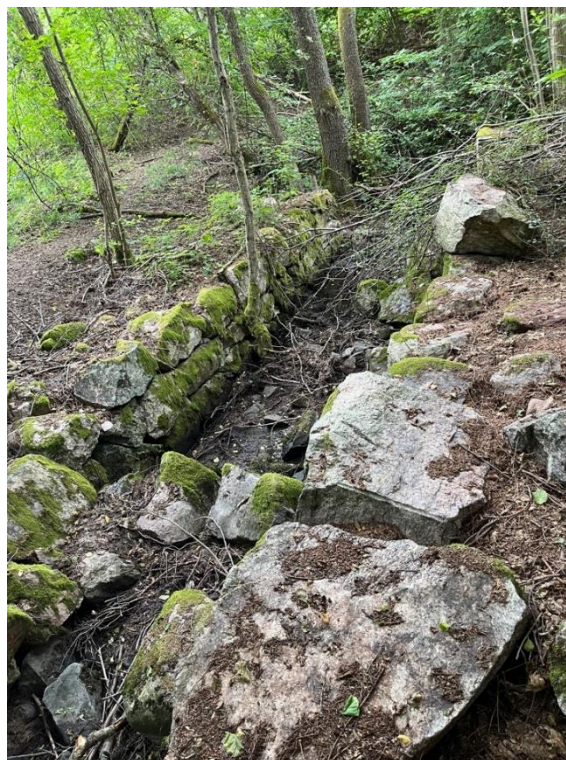
Figur 54 murarna till vattenrännan är kvar
