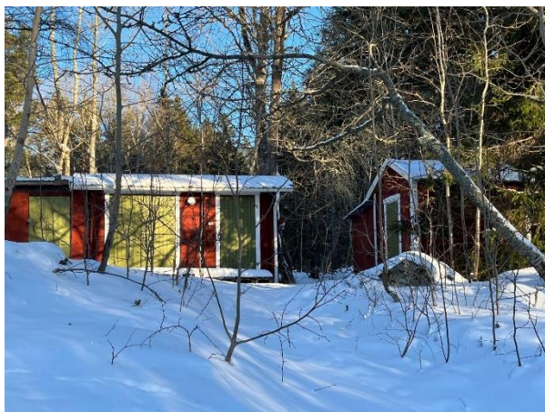
Figur 35 Molinelund, Vinberga 1:12, komplementbyggnader nr. 2
