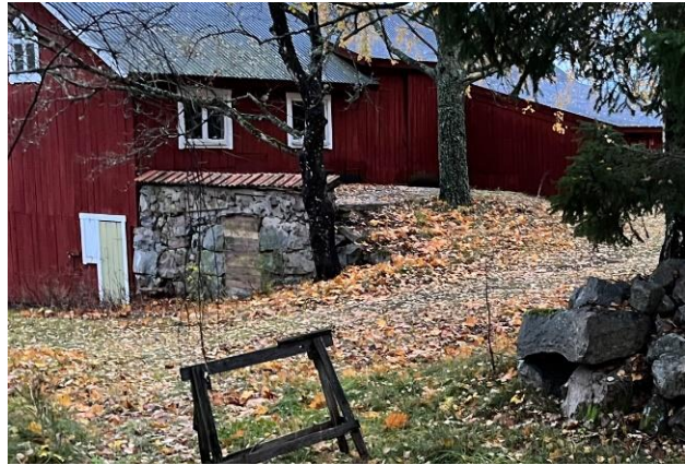
Figur 24 Kallmurad jordkällare, Karlsborg, Vinberga 1:15
