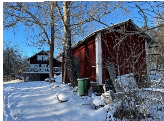
Figur 11 Komplementbyggnad nr. 1 på Bränntorp 1:10
