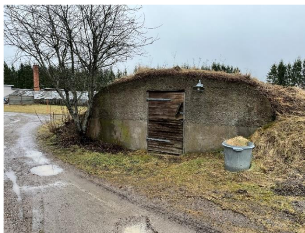
Figur 56 Bränntorp 2:3 med Jordkällare
