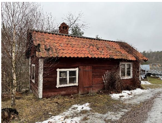
Figur 44 Vinberga 1:11, byggnad nr. 1
