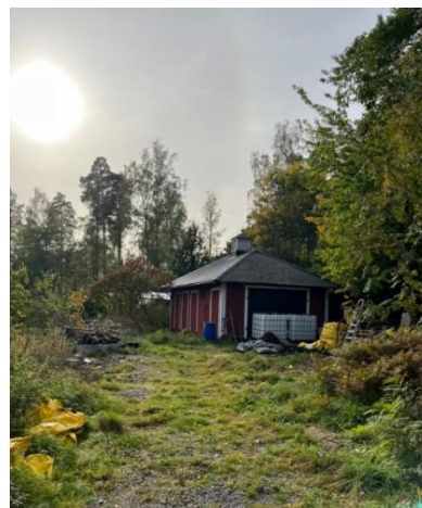
Figur 104 Kämparo, Väsby 1:29, komplementbyggnad nr. 2.
