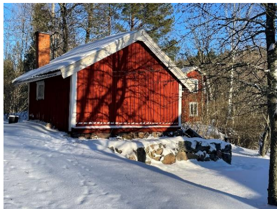
Figur 106 Exempel på terrassering i kombination med förhöjd sockel på Vinberga 1:15
