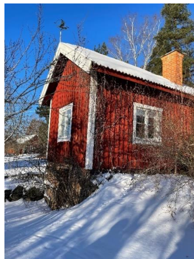
Figur 99 Exempel på förhöjd sockel vid gavel
