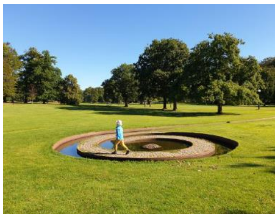
Figur 49 Inspirationsbild, torrdamm. Källa: Dagvattenutredning, Norconsult, 2024
