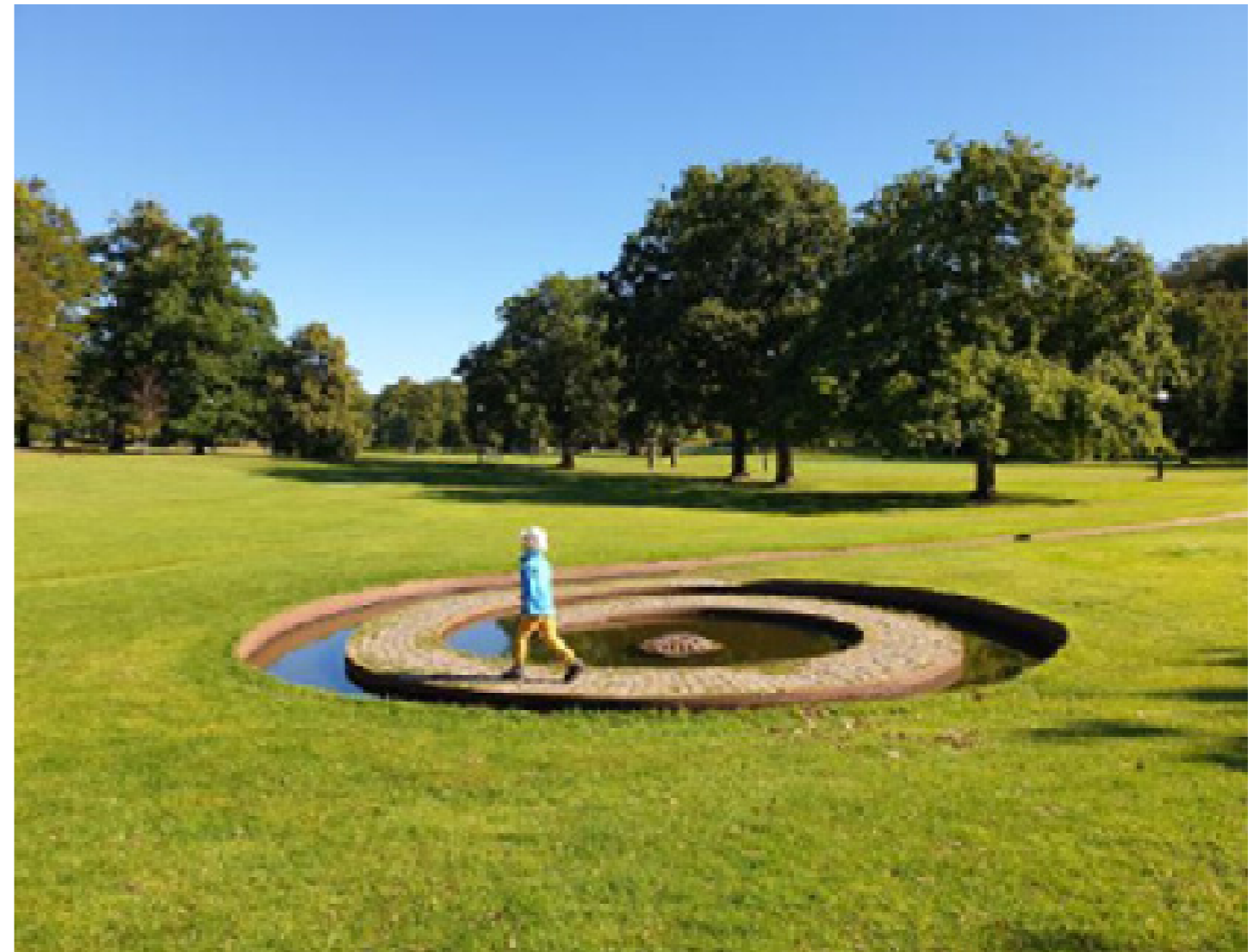
Exempel på multifunktionell torrdamm. Källa: Dagvattenutredning, Norconsult, 2024
