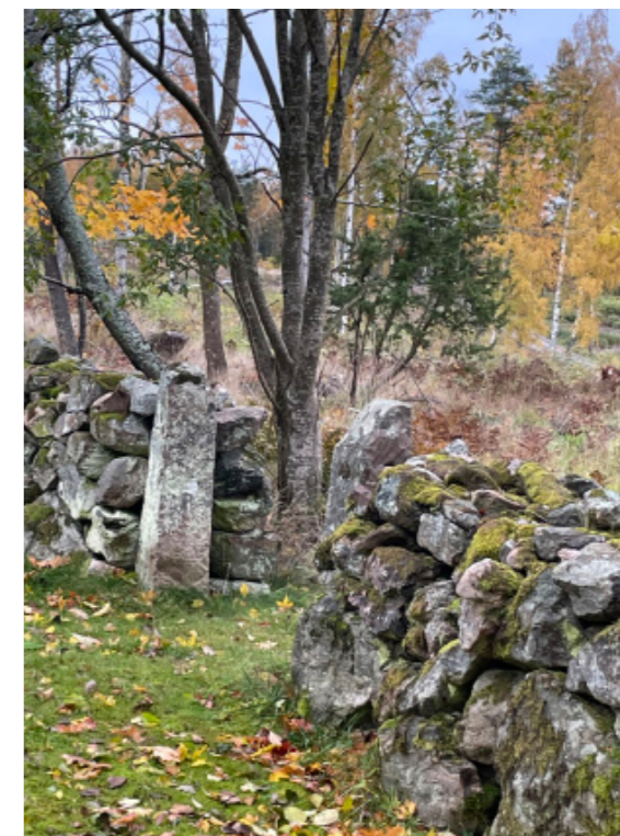
Bild av mur med varsamhetsbestämmelse. Foto: Emma Tibblin, 2023
