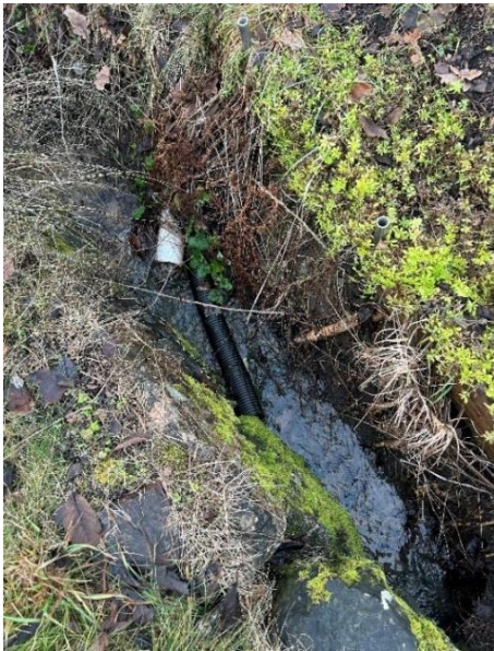
Figur 20. Utlopps rör identifierade vid inmätning, foto av Rickard Pettersson Pontarius
