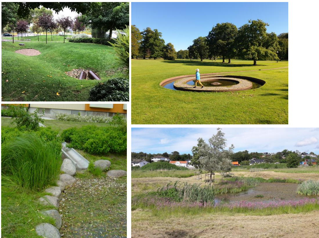
Figur 4.6. Exempelbilder på dammar utformade för fördröjning. Foto: Norconsult AB.
