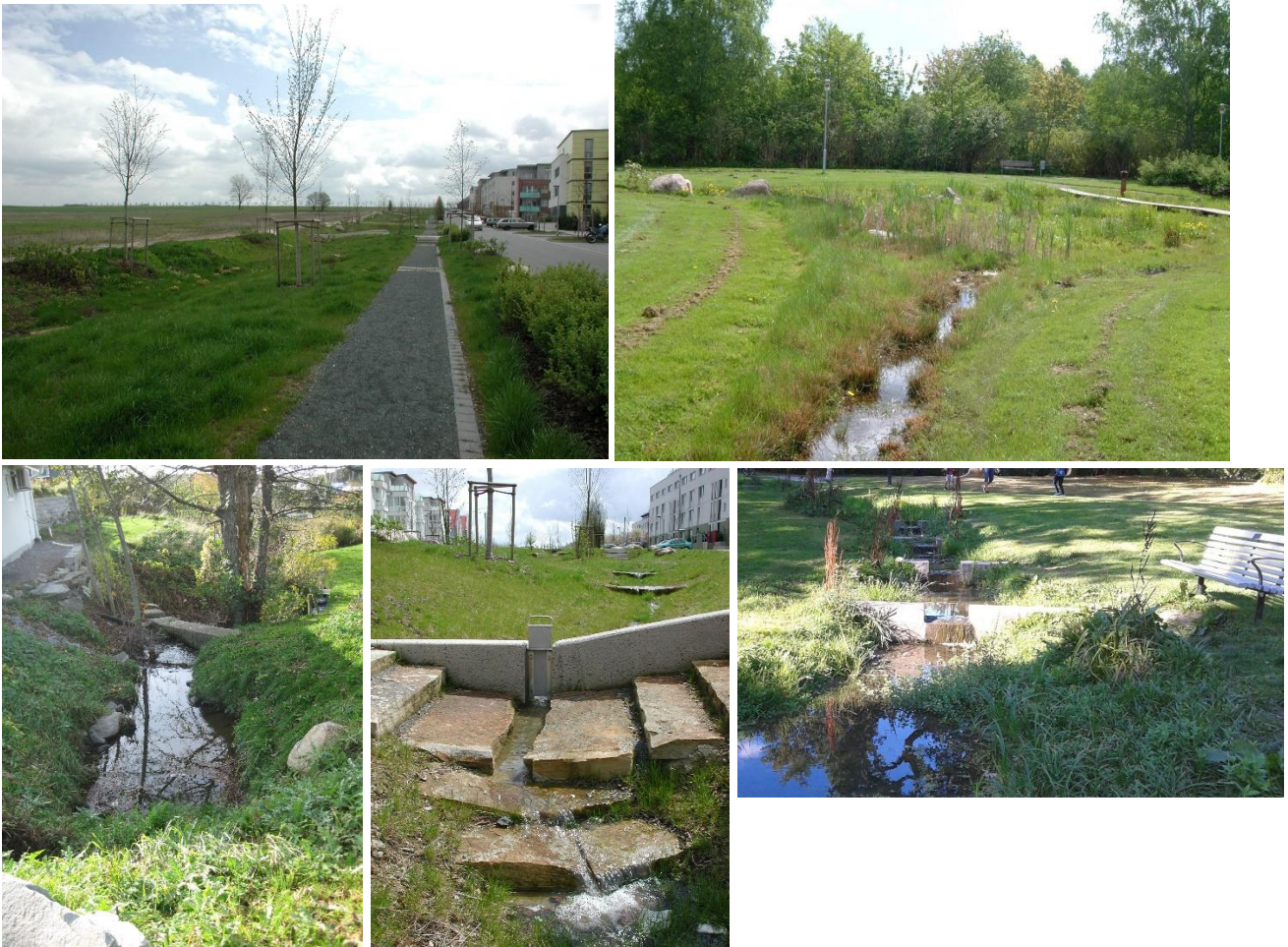
Figur 4.5. Exempelbilder på svackdiken och svackdiken med vallar, Foto: Norconsult AB.
