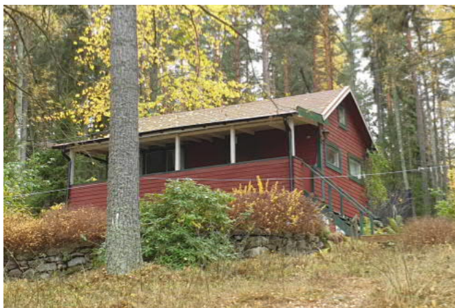
Brännatorp 1:1, byggnad nr. 17
