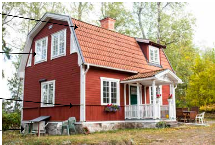
Exempel på egenskaper och karaktärsdrag för en byggnad.
