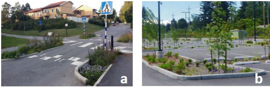
Figur 8. Regnrabatter för a) hastighetsbegränsning vid övergångsställe i Tyresö (källa: Thomas Larm, Rent Dagvatten), b) en parkeringsyta i Washington State, USA (källa: http://www.watershedco.com ).
