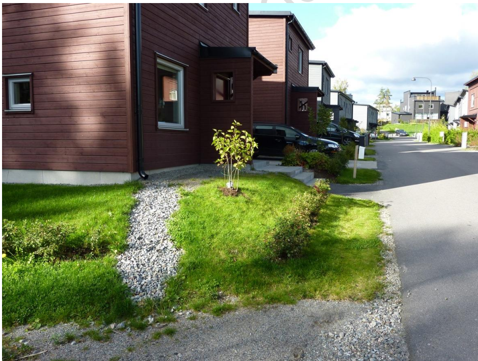
Figur 9. Exempel på bostäder med utkastare från stuprör. Här med avledning till infiltrationsdike med porös fyllning och dränering utmed gata (källa WRS).
