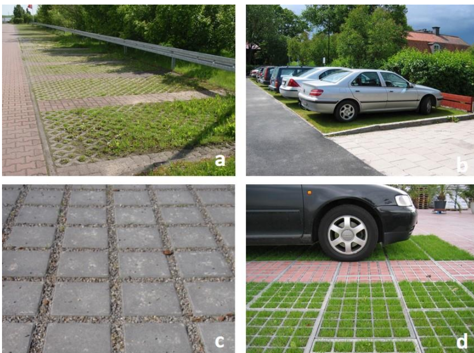
Figur 11. Exempel på användning av genomsläppliga material på parkeringsytor. a) gräsarmering med betonghålsten (källa WRS), b) gräsarmering med "Pelleplatta" (källa www.vegtech.se ), c) marksten med glesa, genomsläppliga fogar (källa WRS), d) gräsarmeringsplattor (källa: alltimark.se ).
