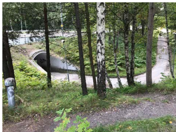
Gångtunnel under Enhörnaleden.
